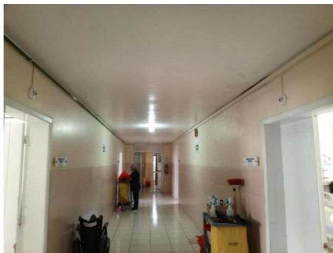
Anexo B – 3 Revisión de la iluminación en los pasillos
