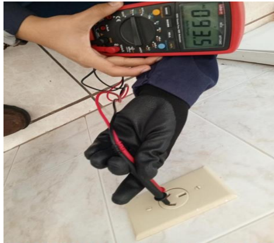
Anexo B – 4 Revisión de tomacorrientes
