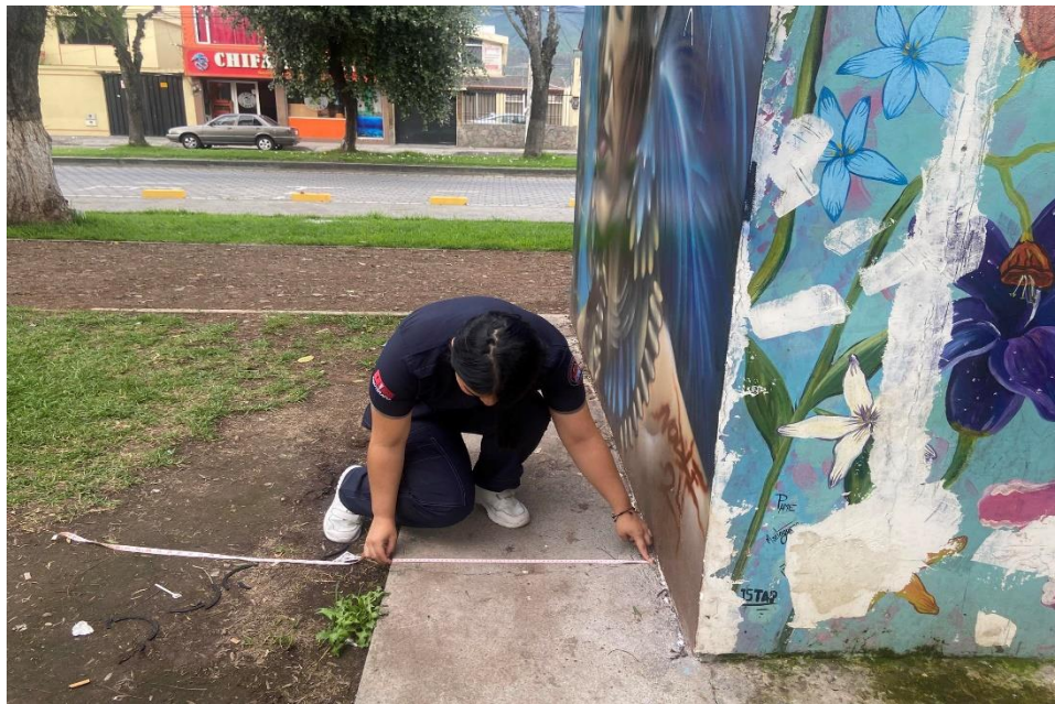
Figura 8. Evaluación de zona de ingreso al expendio de comida.
