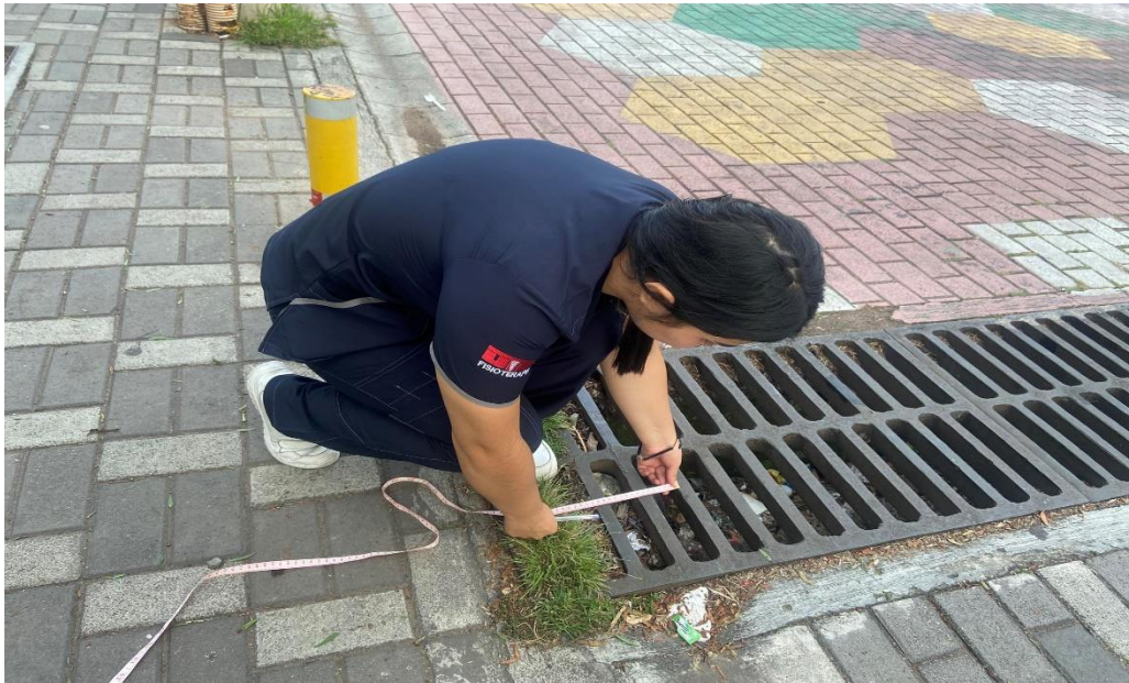
Figura 4. Toma de dimensión en rejilla para drenaje.
