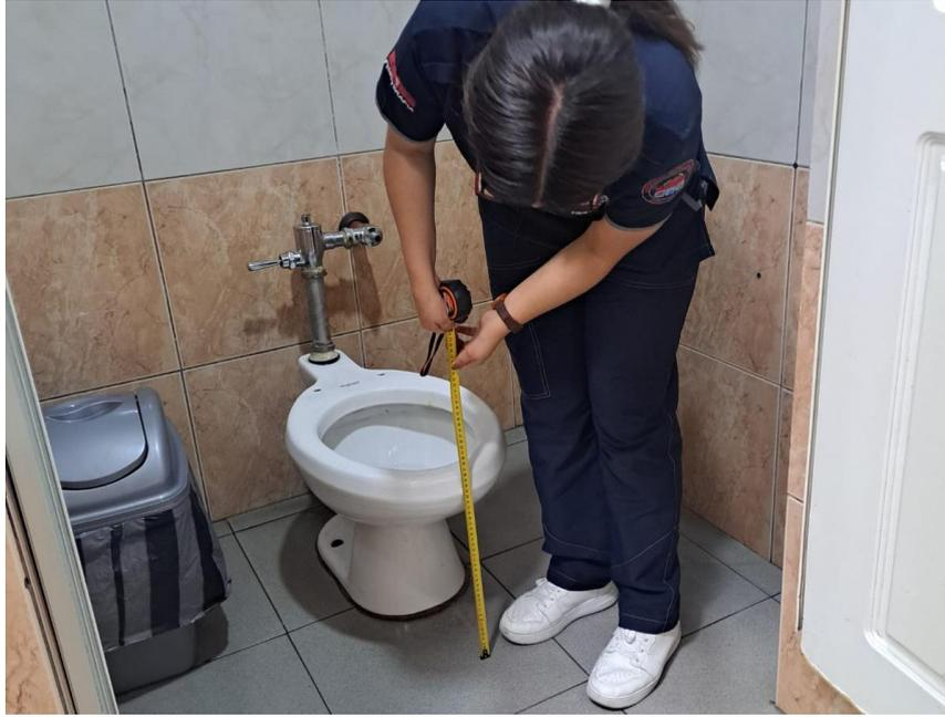
**Figura 9.** *Medición de la altura del inodoro.*
