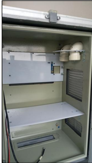
Fig. 4.89 Envolverte con piezas de acrílico instaladas
