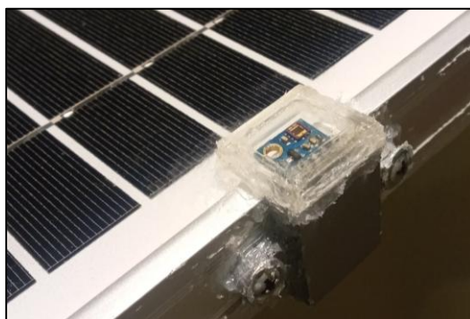
Fig. 4.96 “Cubierta de protección del sensor UV” instalada.
