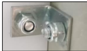
Fig. 4.68 Ángulo de 16 mm instalado en envoltente.
