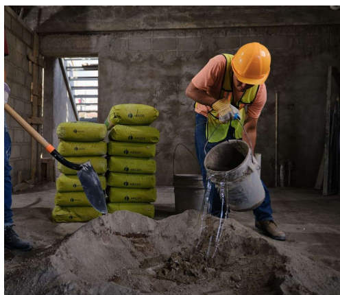
Figura 2.3: Mezcla de cemento durante la construcción [3].
