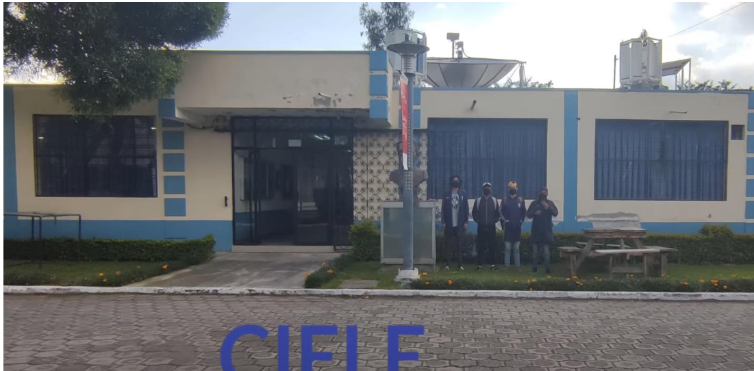
Figura. 13. Laboratorios de Electricidad.
