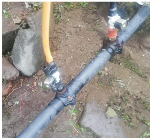
Fig. 23 Electroválvulas instaladas
