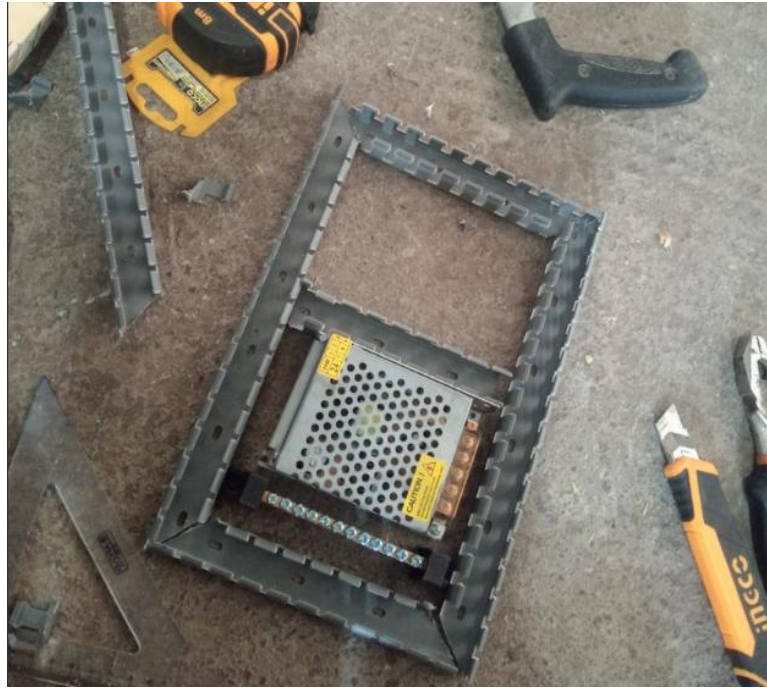
Fig. 4.0.42 Instalación de estructura base del gabinete eléctrico.
