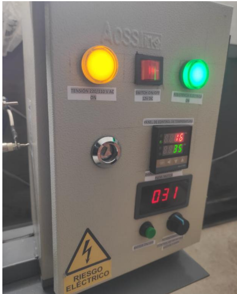
Fig. 4.0.46 Pruebas y Verificación el control.
