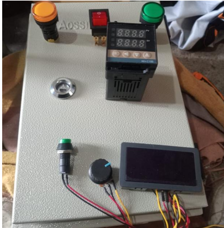
Fig. 4.0.45 sistema de control eléctrico y electrónico de la máquina.
