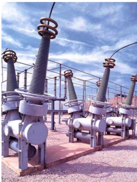
Figura 13. Disyuntor de potencia [38].
