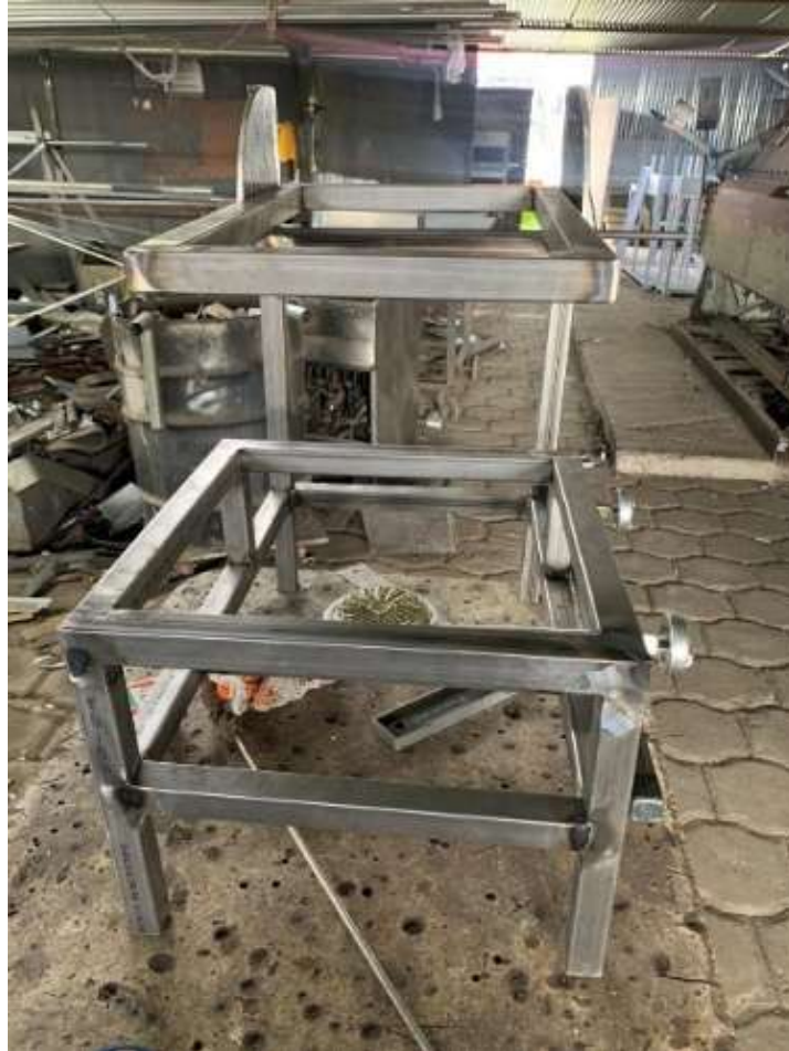
Fig. 4.25 Ensamblaje de estructura metálica
