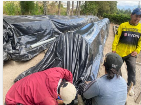
Figura 10: Instalación de Invernadero
