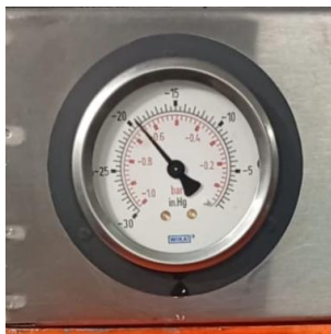
Figura 28 Uso del vacuómetro para la comprobación de estanqueidad
