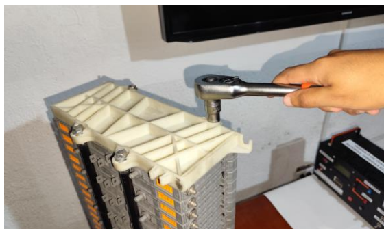
Figura 37. Extracción de los módulos de Ni-MH de la batería HV.
