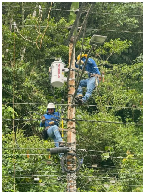
Nota: Montaje y conexión de transformador
