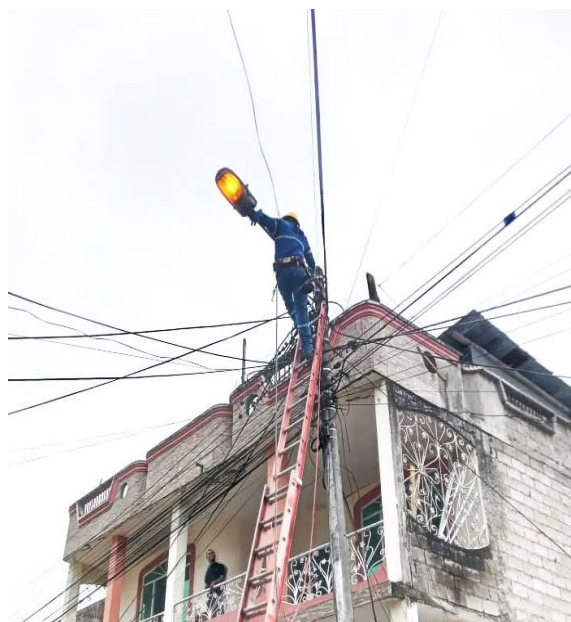
Nota: Reparación de luminaria
