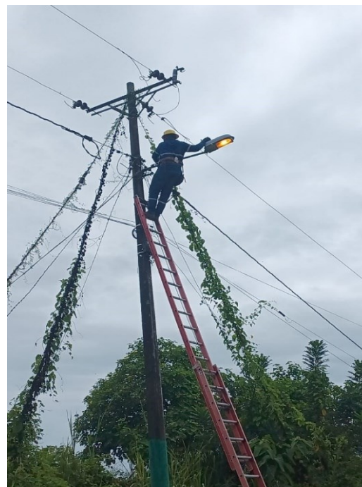
Nota: Reparación de luminaria
