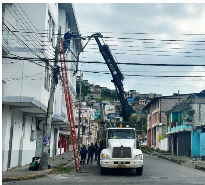
Nota: Instalación de luminaria
