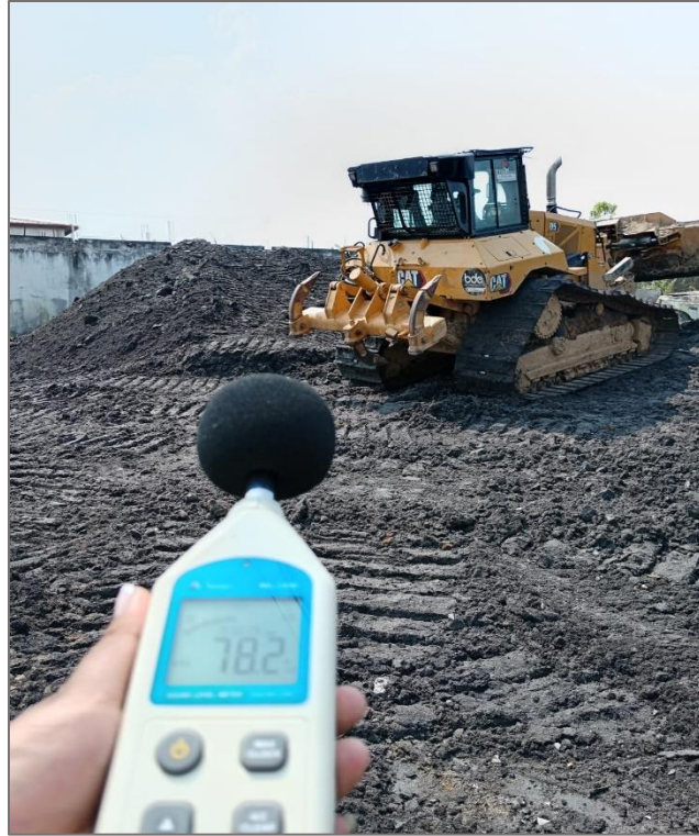
Ilustración 7. Estudio maquinaria pesada en campo.
