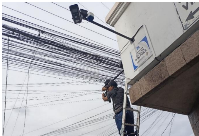
Figura 11. Instalación de equipos (Autoría Propia)
