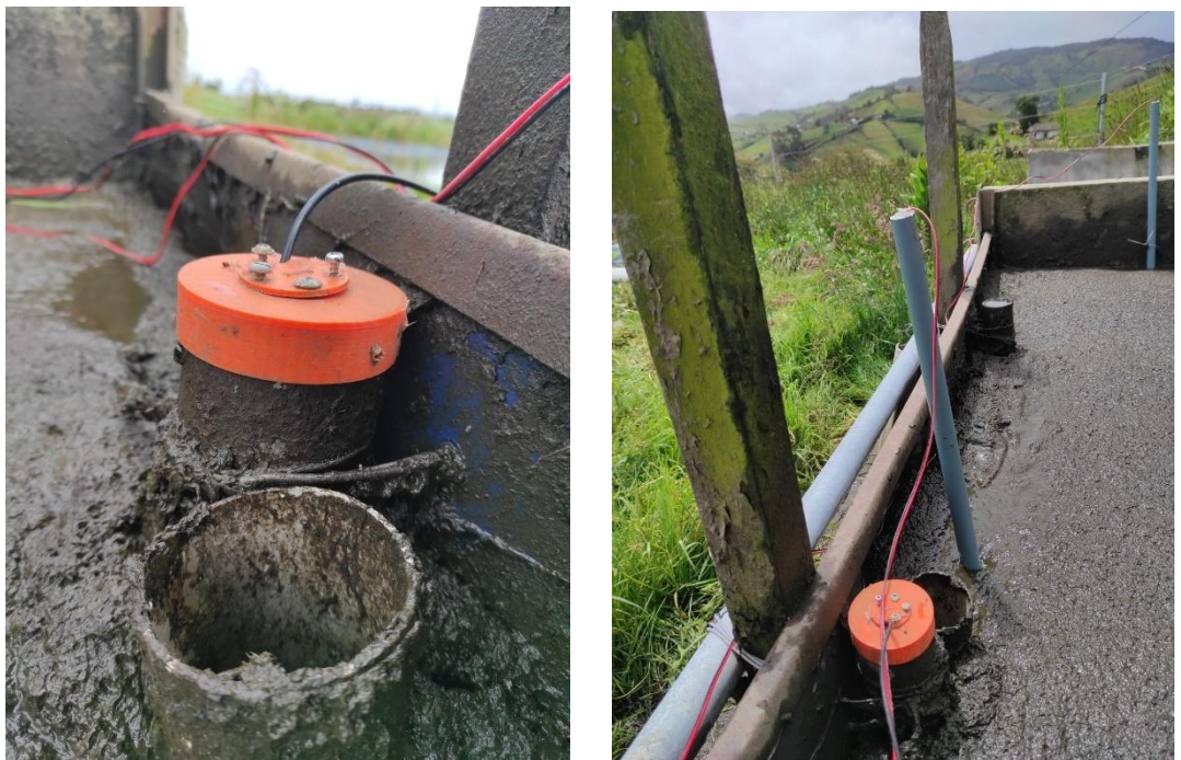
Figura 49 Sensores instalados con protección de tubo PVC
