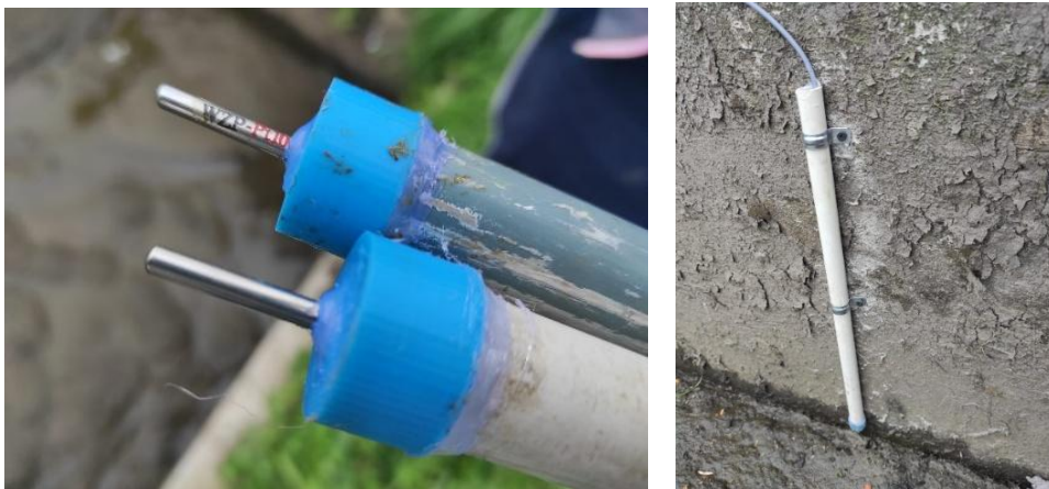
Figura 40 Instalación de los sensores de temperatura al contacto
