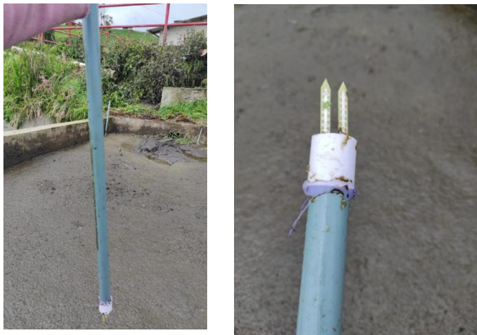
Figura 41 Instalación de los sensores de humedad
