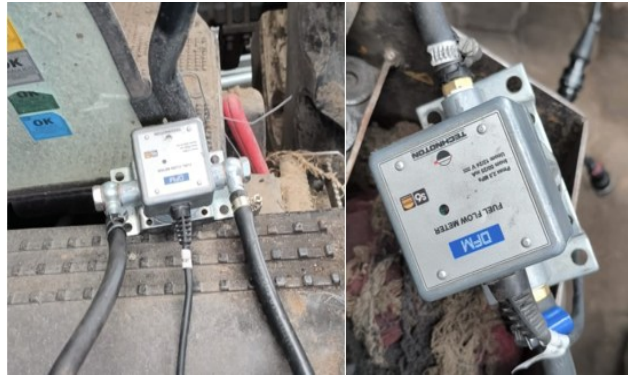
Figura 23. Instalación de flujómetros
