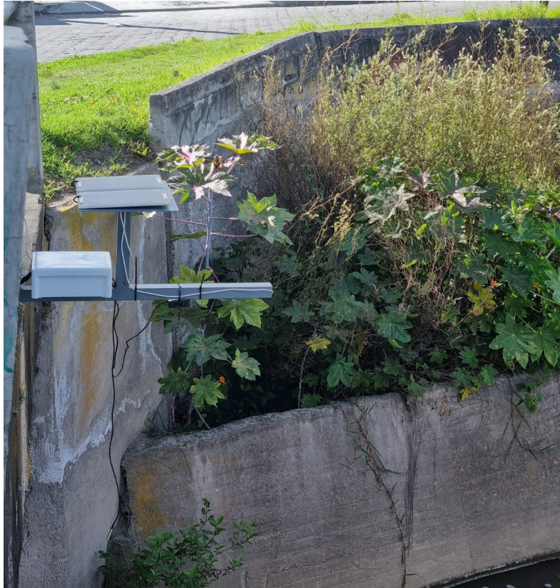
Figura 5.1: Estructura metálica instalada en la zona de monitoreo
