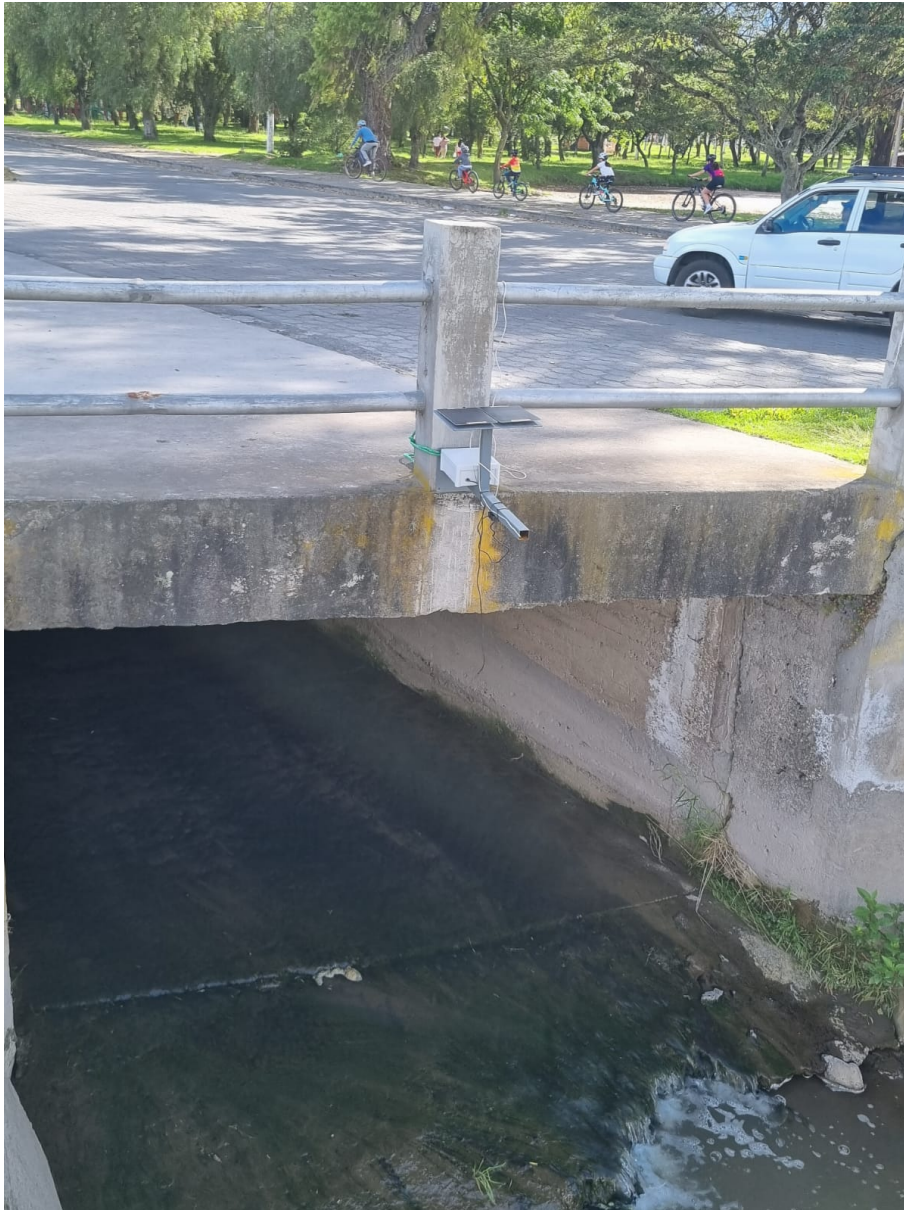
Figura 0.2: Instalación del dispositivo parte 1
