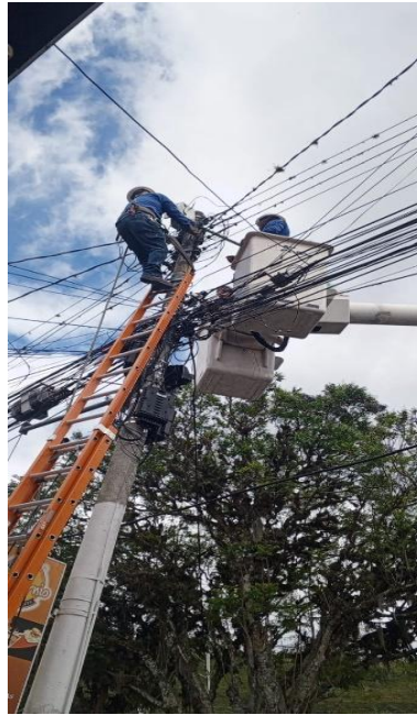
Fig 71. Desmontaje de las luminarias para la colocación de las luminarias IoT.
