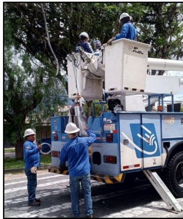
Fig 70. Apoyo del personal técnico de EMELNORTE durante el montaje del sistema de iluminación.
