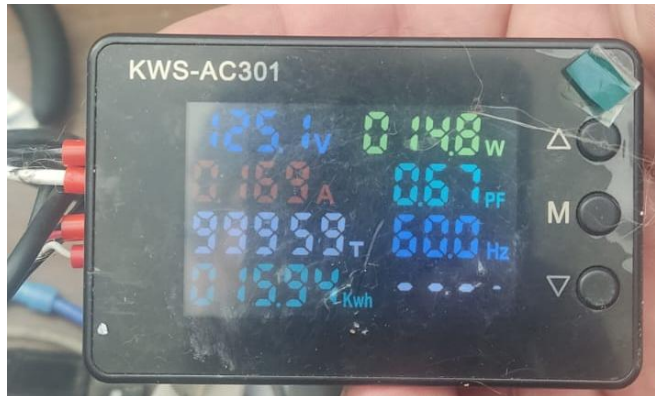
Fig 56. Medidor digital de energía modelo KWS-AC301.
