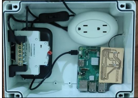
Fig 65. Montaje del sistema central de supervisión.
