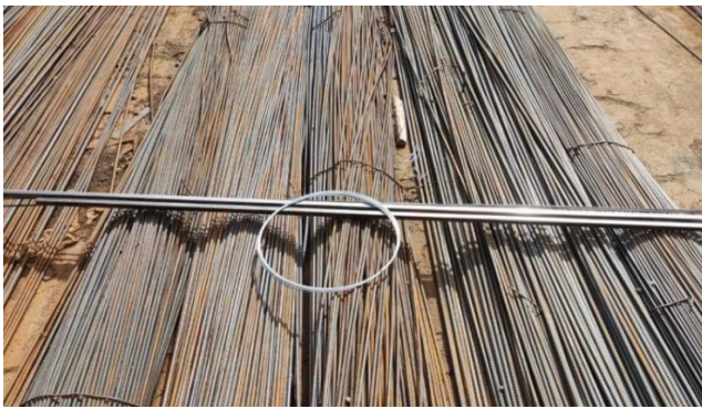
Figura 27 Adquisición de materiales para la base de la estructura.
