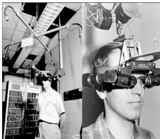
Figura. 2. Sword of Damocles: primer visor montado en la cabeza
