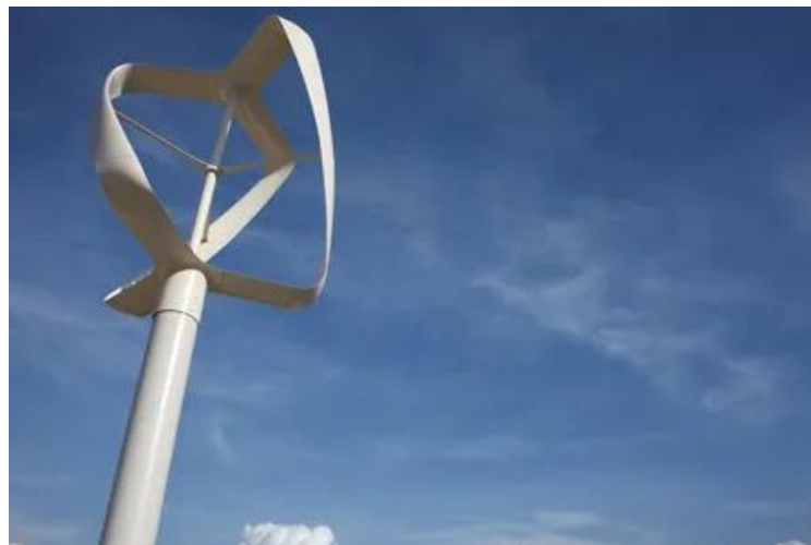
Figura 5. Aerogenerador con rotor Darrieus [30]
