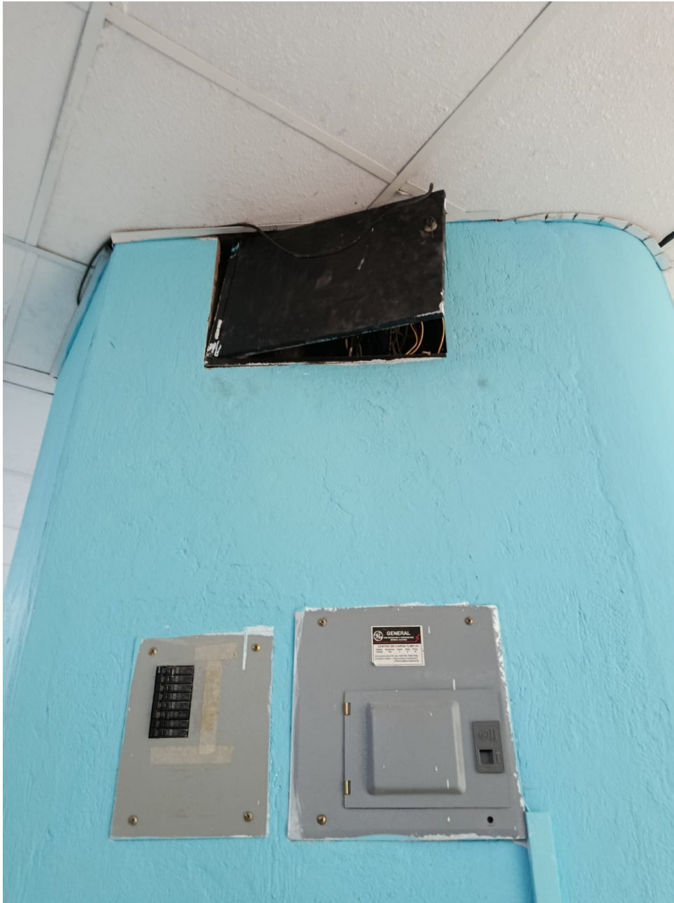
Figura A.1. Inspección visual del pilar
