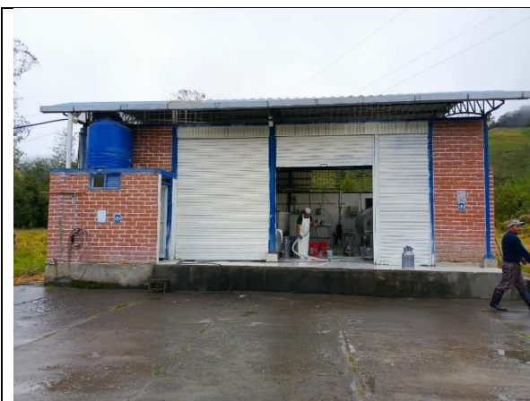
Vista frontal del Centro de Acopio
