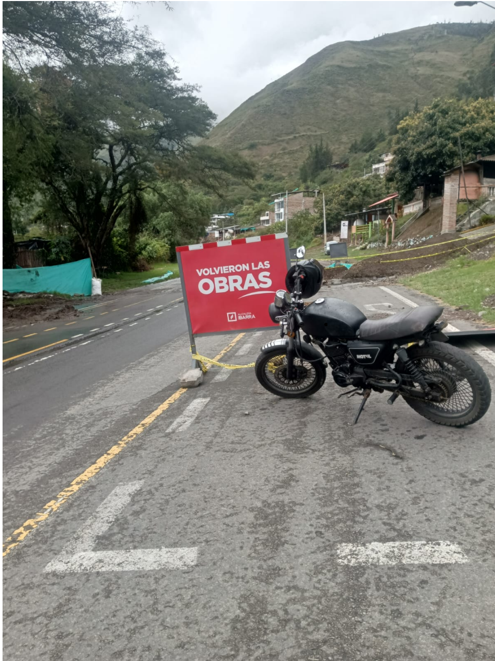
Fig. E.3 Señalización de los trabajos en la zona.
