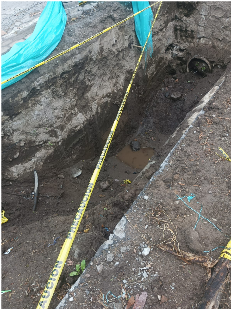
Fig. E.1 Trabajos en las tuberías de las afluentes.
