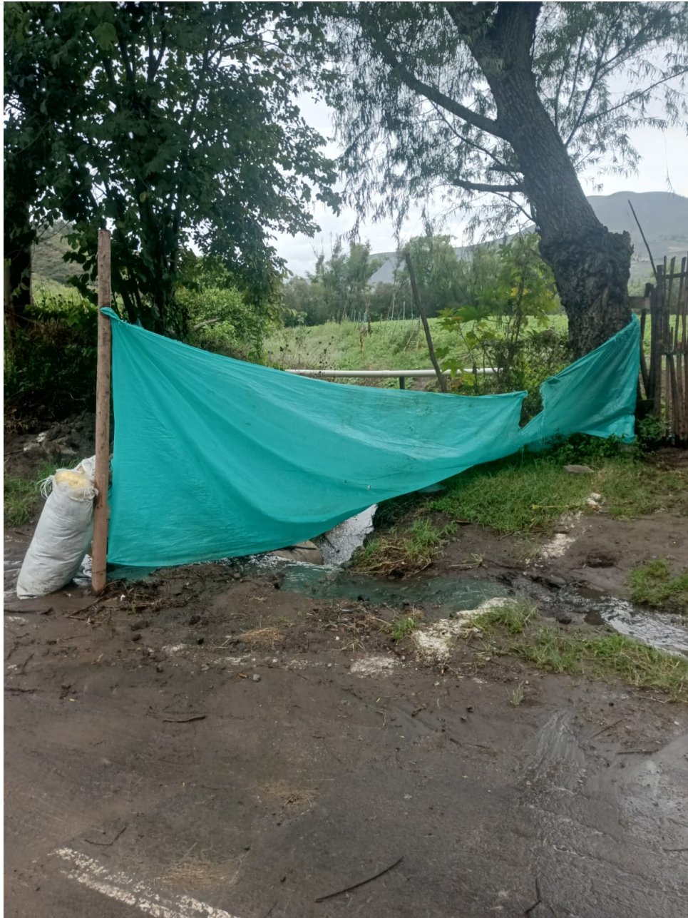
Fig. E.2 Trabajos en la zona superior de las afluentes.
