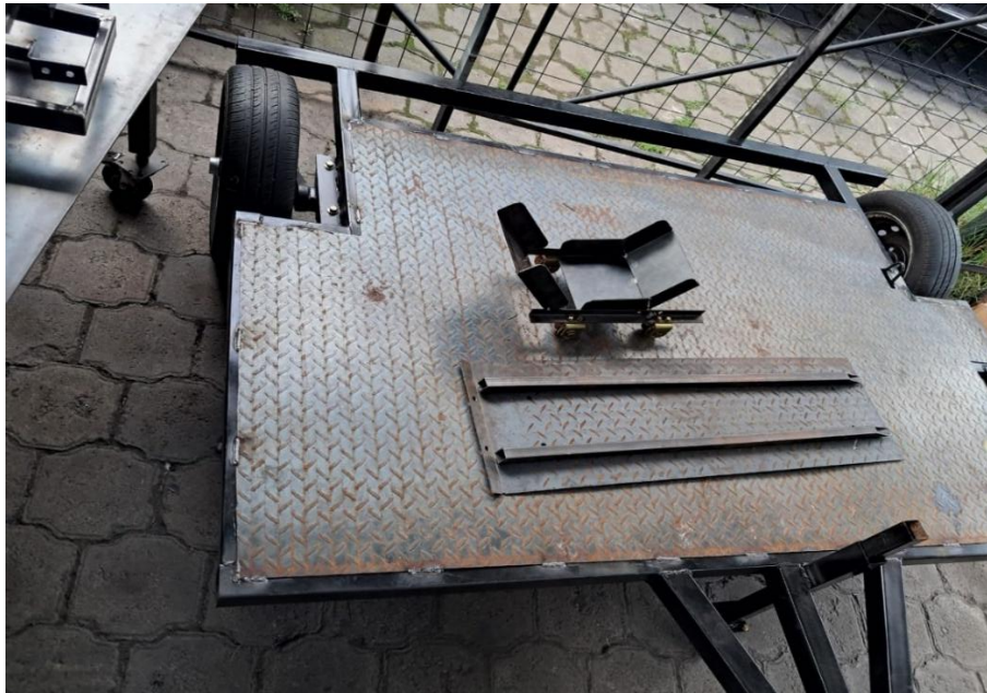
Figura 67 Fabricación del Piso y Rampa de Ascenso
