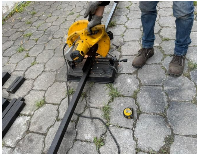
Figura 60 Corte de Tubos Según Dimensiones de Diseño
