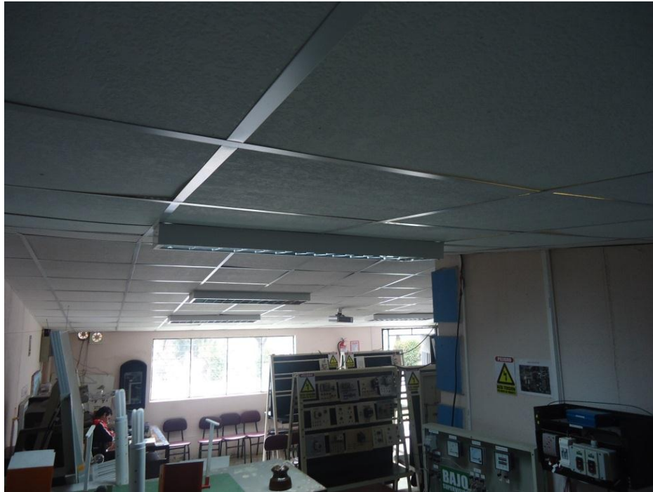
CUBIERTA ACTUAL DEL LABORATORIO DE LA CIMANELE
