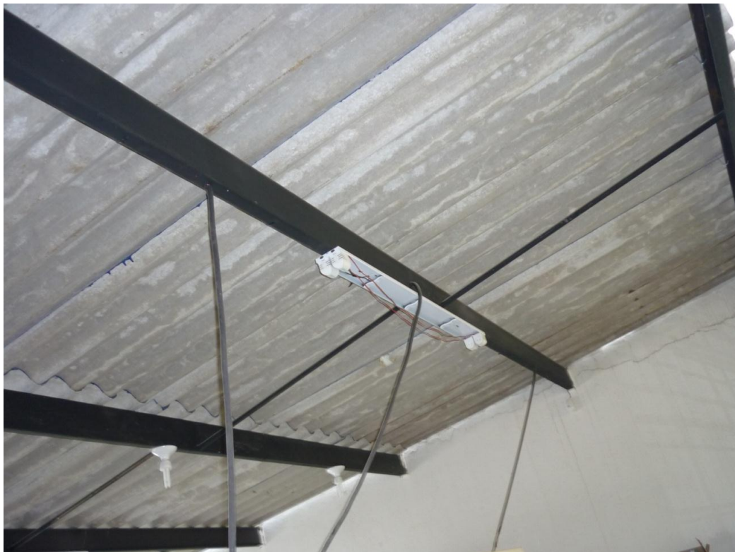
LUMINARIAS INADECUADAS PARA LA ILUMINACIÓN DEL LABORATORIO DE LA CIMANELE
