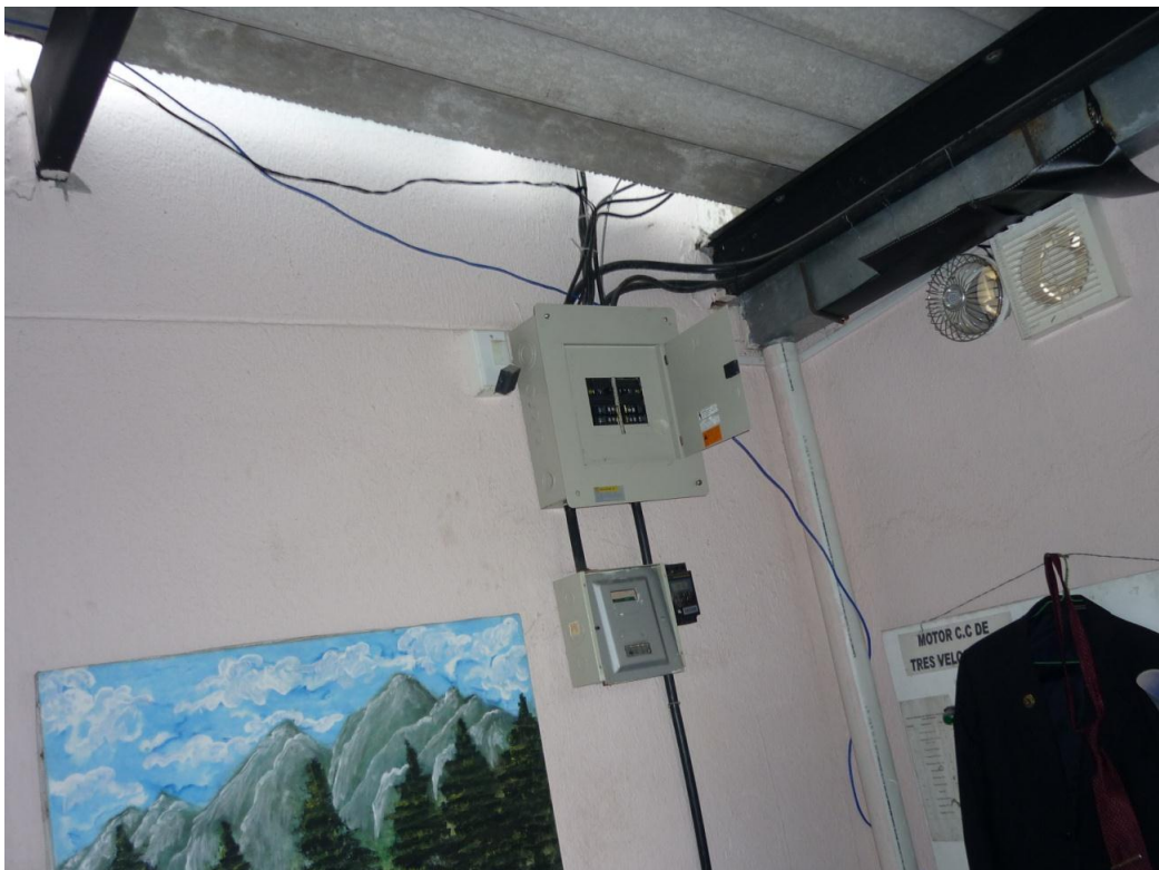
CAJA GENERAL DE PROTECCIONES DE LA CIMANELE
