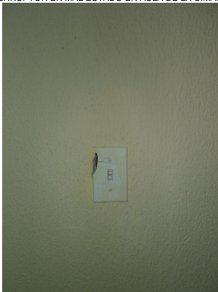
INTERRUPTOR EN MAL ESTADO EN AULA DE LA CIMANELE
