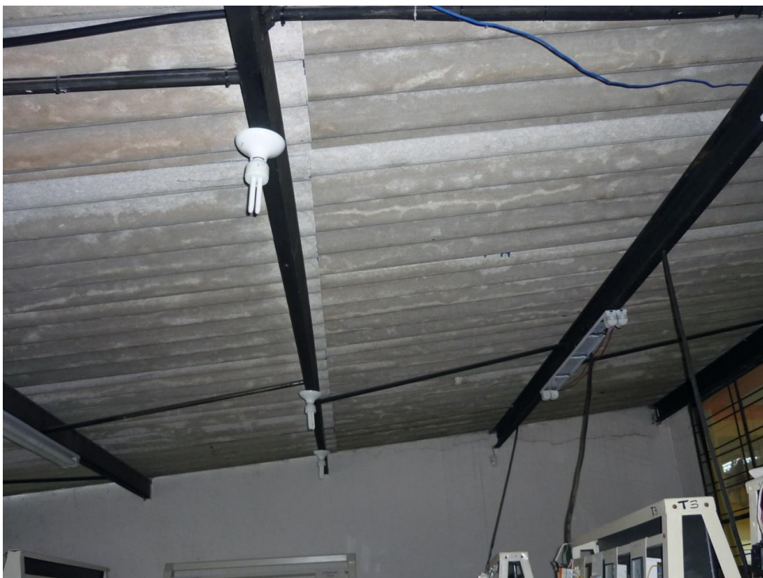
LUMINARIAS INADECUADAS PARA LA ILUMINACIÓN DEL LABORATORIO DE LA CIMANELE
