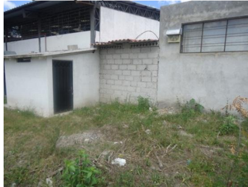
Figura 46. Lugar elegido para la construcción del proyecto.
