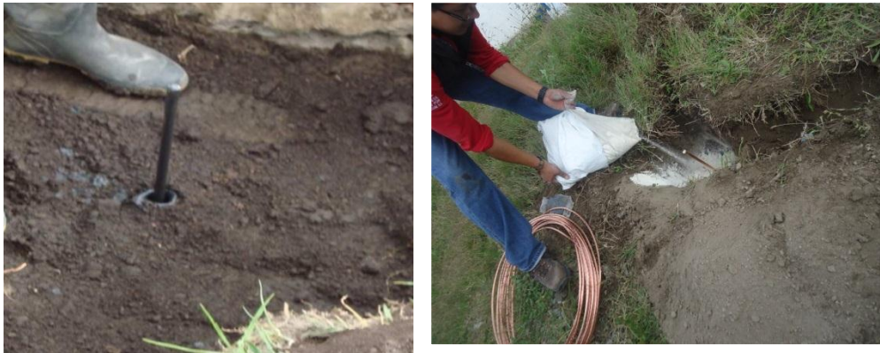
Figura 50. Introducción del electrodo sobre el GEM y el relleno.
