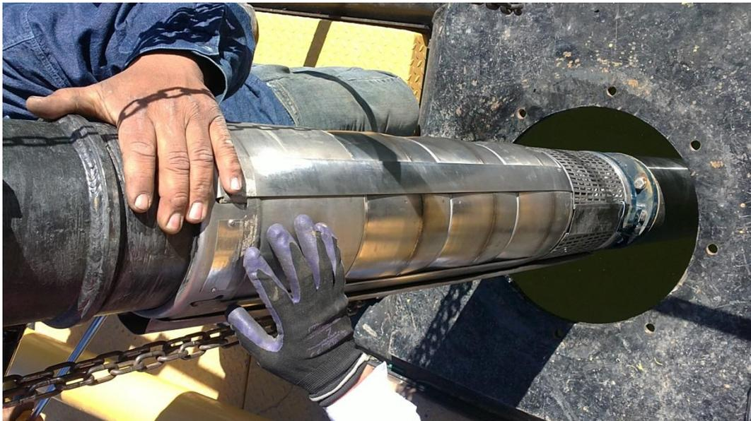
**Foto: Nº 1 Instalación de la bomba sumergible**
