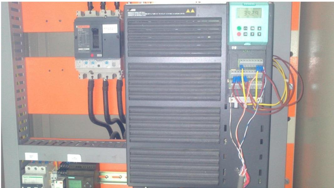
**Foto: N° 4 Pruebas de funcionamiento del variador (modulación del transductor)**
