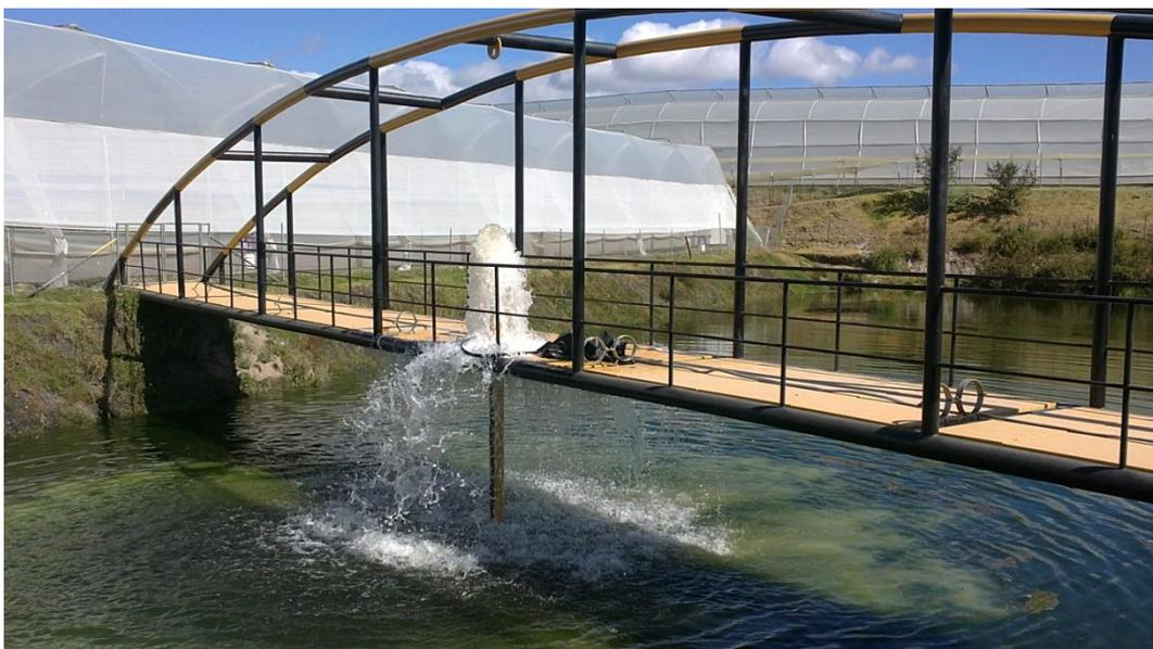
**Foto: Nº 2 Pruebas de funcionamiento de la bomba sumergible**
