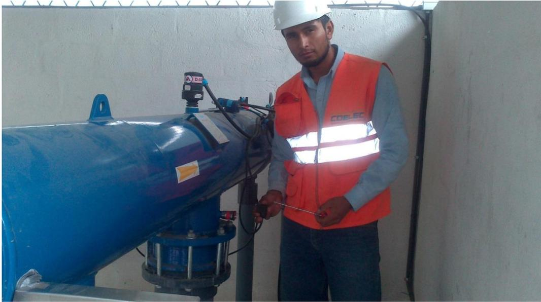
**Foto: N° 3 Instalación del transductor de presión**
