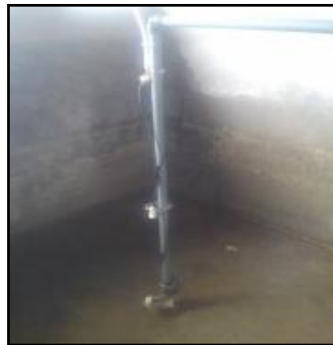
Figura 2-4: Ubicación de flotadores en el tanque
