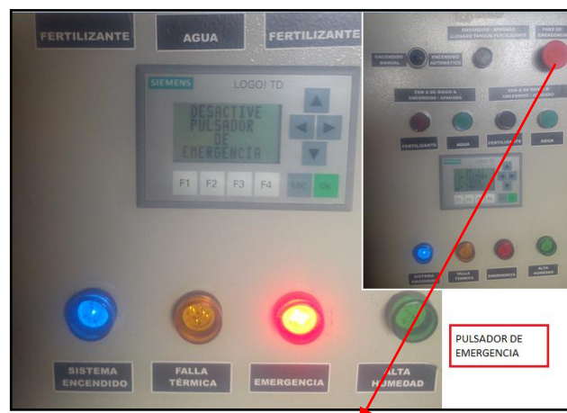
Figura 4-7: Pruebas del pulsador de emergencia
