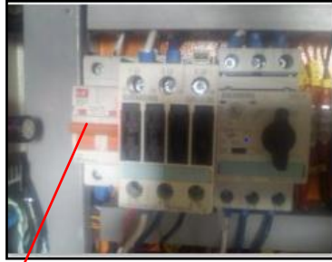
Figura 2-6: Interruptor de encendido de todo el sistema
