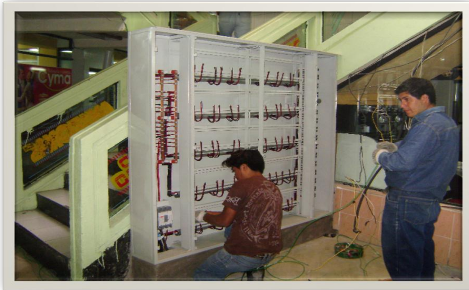
Instalación de un tablero en un centro comercial
