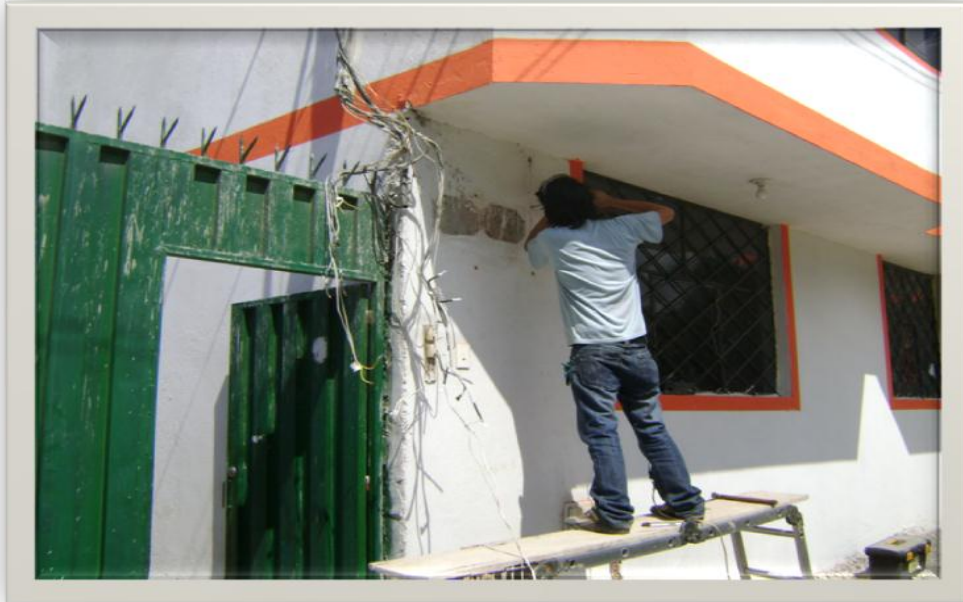
Proceso de instalación de tablero
