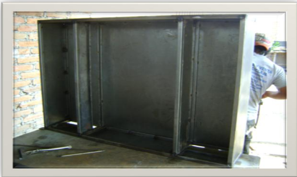
Concluida la primera fase de fabricación del tablero
