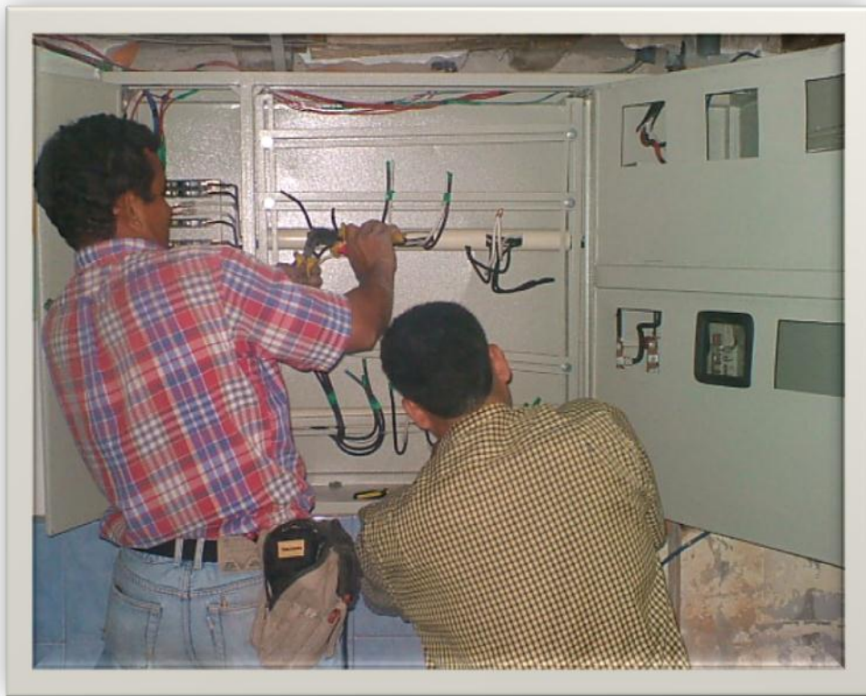
Cableado de un tablero especial trifásico.
