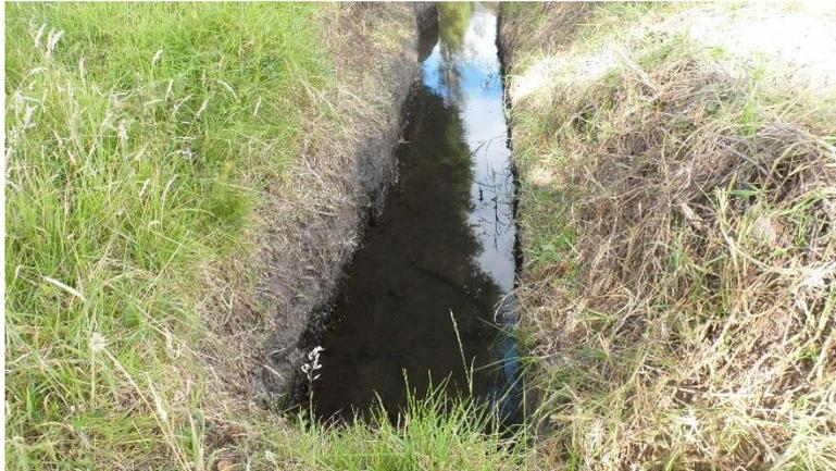
**Fotografía 4.12** Tramo 3 (canal sin revestimiento)
