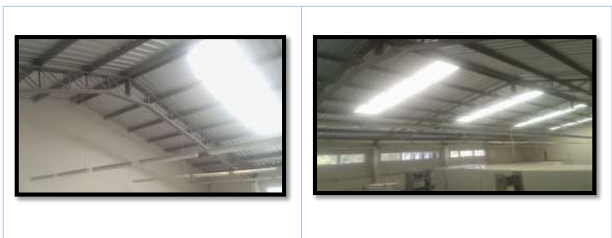
ILUSTRACIÓN 4.52: Techos antes y después de la implementación.
