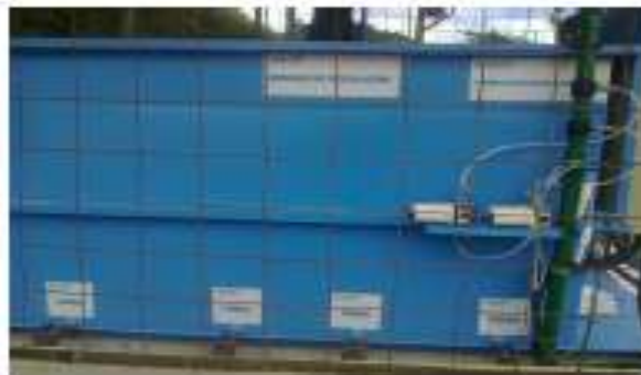
Figura 3.3 Dosificación de PAC y Cloro
