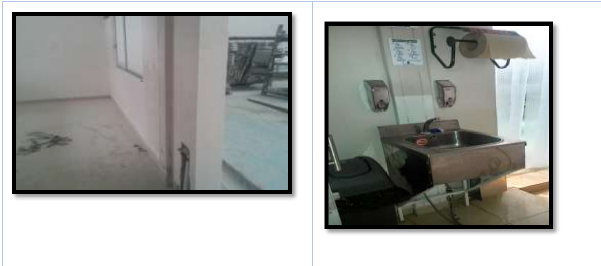
ILUSTRACIÓN 4.60: Estación de lavado de manos antes y después de la implementación.
