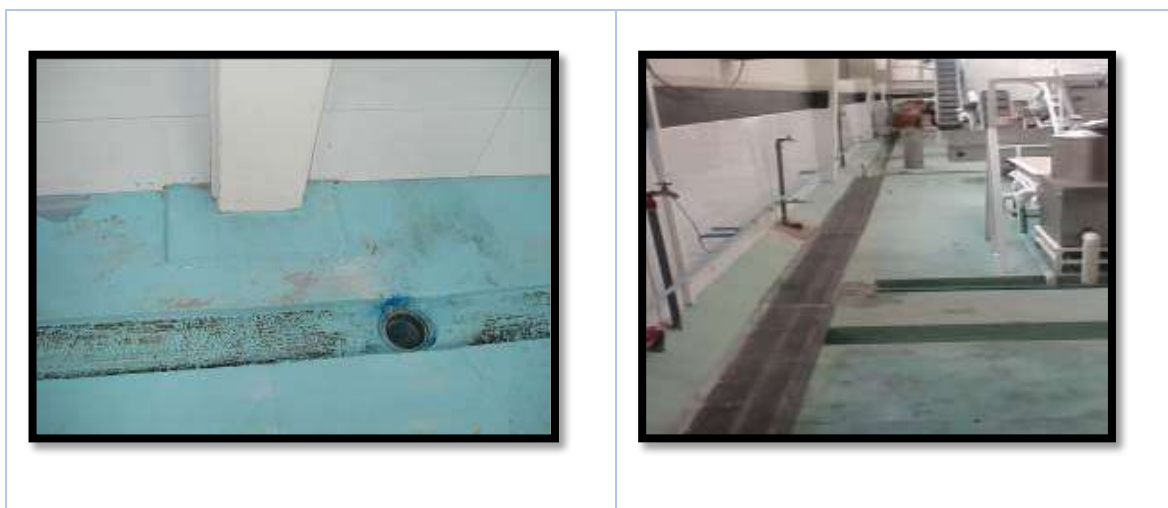
ILUSTRACIÓN 4.50: Drenajes antes y después de la implementación.
