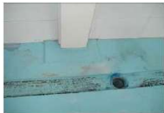
Imagen 16. Canaletas y drenajes.
