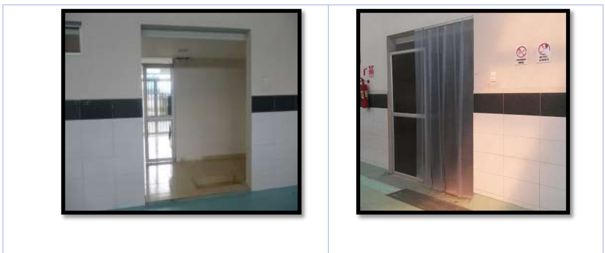
ILUSTRACIÓN 4.55: Puertas antes y después de la implementación.
