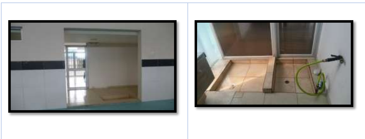
ILUSTRACIÓN 4.61: Estación de lavado y desinfección de botas antes y después de la implementación.
