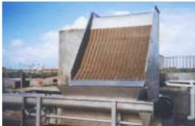
Figura 3.1 Tamiz auto-implante
