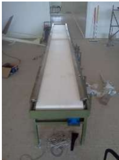
FIGURA 4.10: Montaje del sistema de transporte
