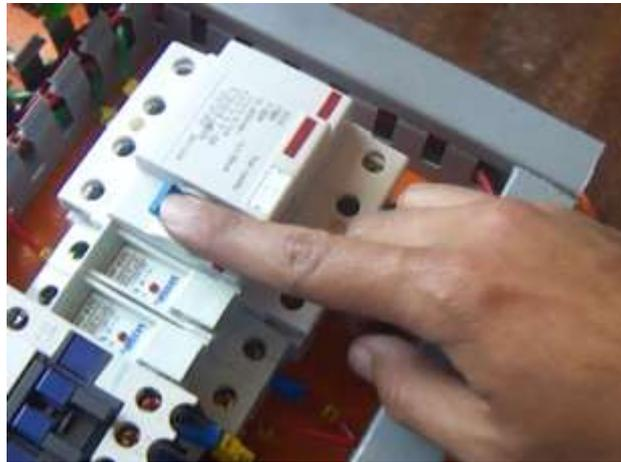
Cuando la máquina no esté en funcionamiento asegúrese de que tanto el interruptor con el switch de encendido del motor se mantengan en modo OFF para mayor seguridad y evitar accidentes posteriores. Además mantener el tablero de control electrónico con la tapa cerrada y ajustada con su respectiva llave.
