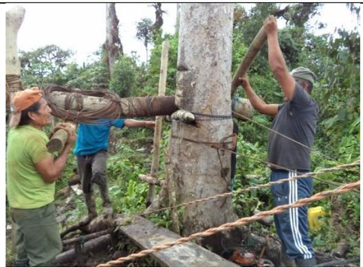
Levantamiento y tensionado del cable principal.
