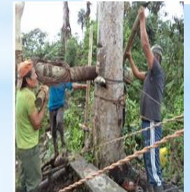
Levantamiento y tensionado del cable principal.
