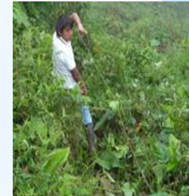
Tendido del cable principal.
