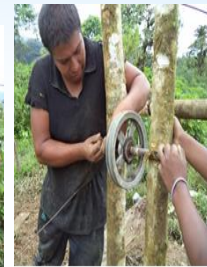
Colocación de las poleas grandes:
