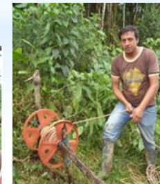
Tendido cabo de Tracción.
