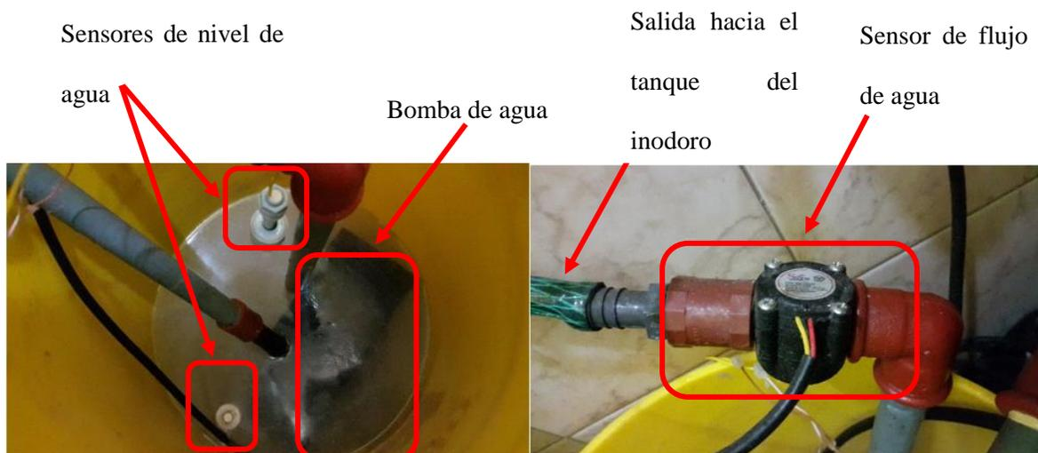
Figura 41. Instalación de la bomba, sensor de flujo y sensores de nivel
