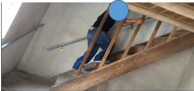
Anexo 17.- Pos implementación y adaptación de ayuda técnica del Caso A Gradas del domicilio del paciente con implantación de dos pasamanos de gradas
