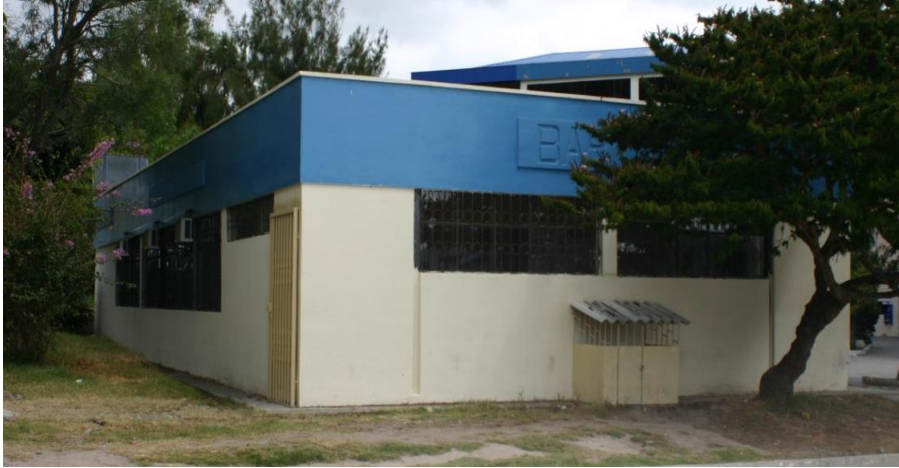
Fachadas lateral y posterior
