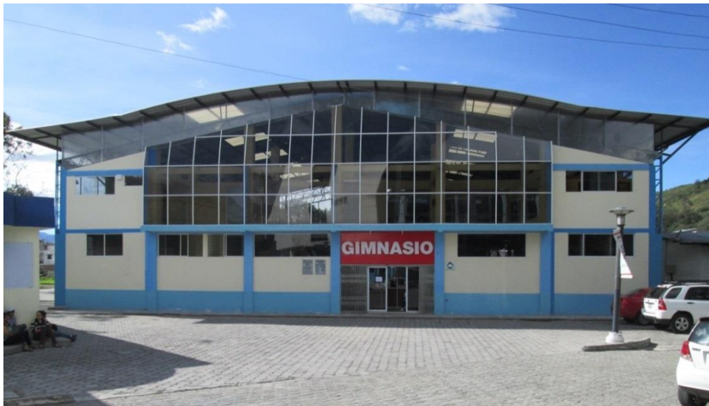
Figura 62: Fotografía del Gimnasio universitario
