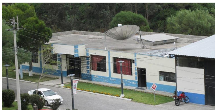
Fachada principal y cubierta
