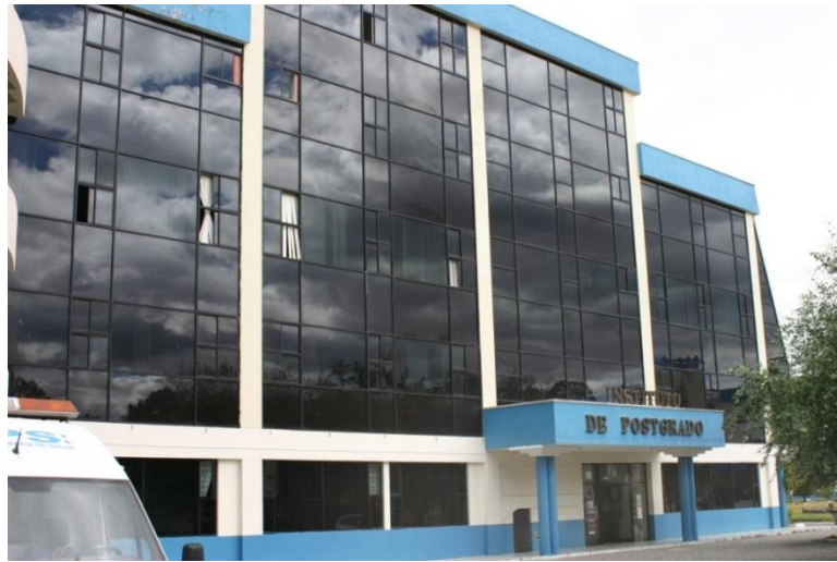
Figura 35: Fotografía del edificio del CAI Fuente: Archivo del autor, Ibarra. 2013
