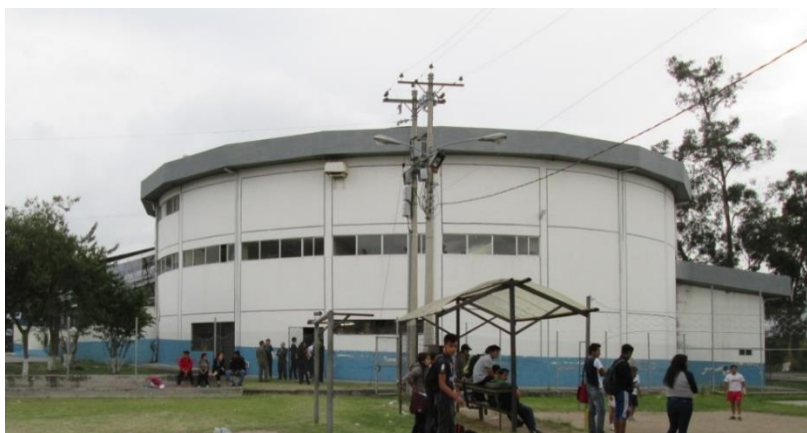
Fachada lateral norte
