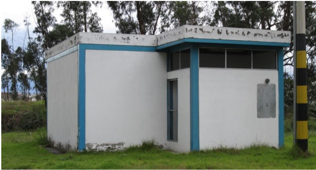
Figura 38: Fotografía de la Casa de Máquinas
