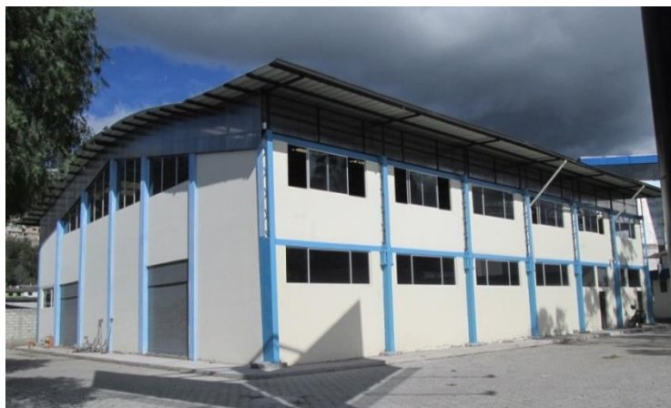
Fachadas posterior y lateral oeste
