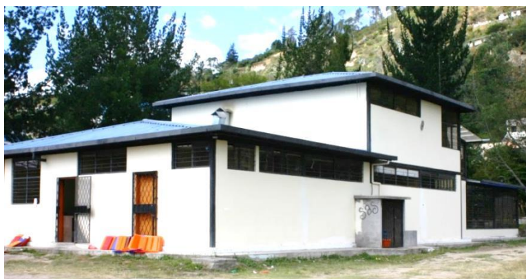
Fachadas lateral y posterior
