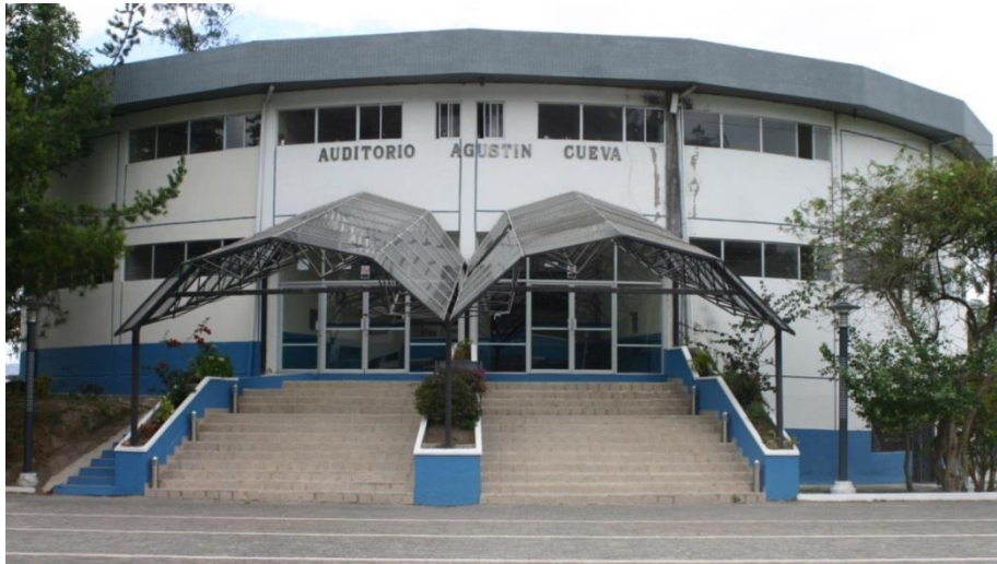
Figura 11: Fotografía de la construcción
