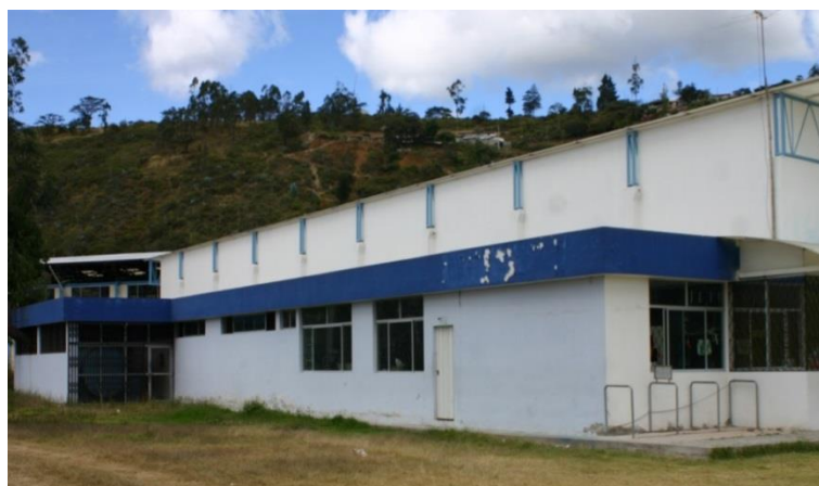
Fachada posterior y cuarto de máquinas
