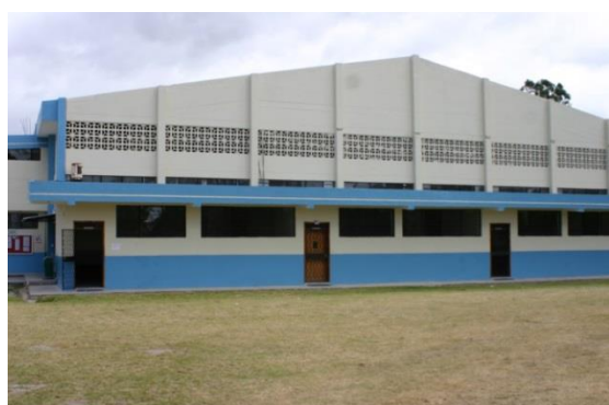
Fachada lateral norte
