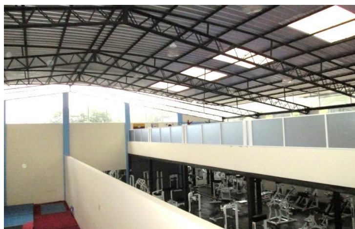
Interior del gimnasio
