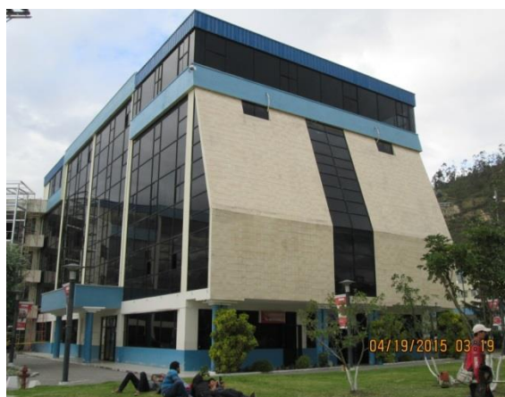
Fachadas oeste y sur
