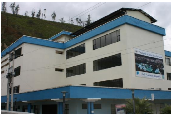
Fachada lateral y posterior del edificio
