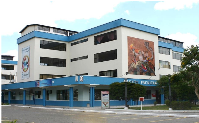
Figura 8: Fotografía del edificio FECYT Fuente: Archivo del autor, Ibarra. 2013
