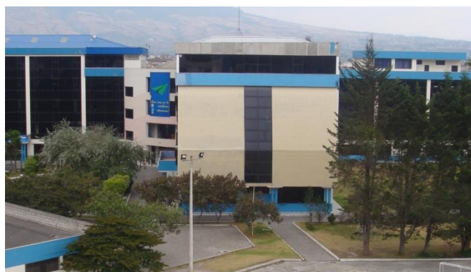
Fachada lateral norte
