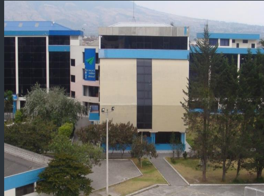
Fachada lateral norte
