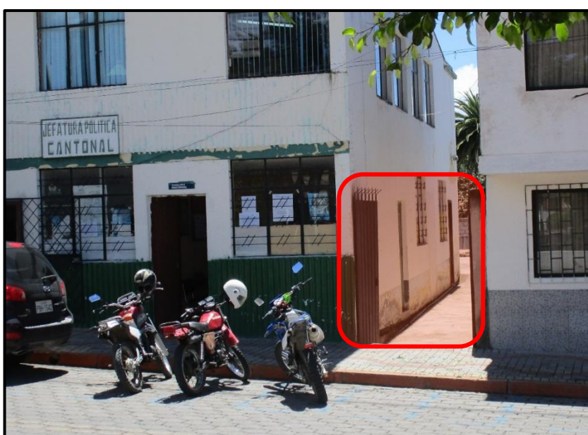
Imagen 2: Puerta de acceso Av. León Rúailes
