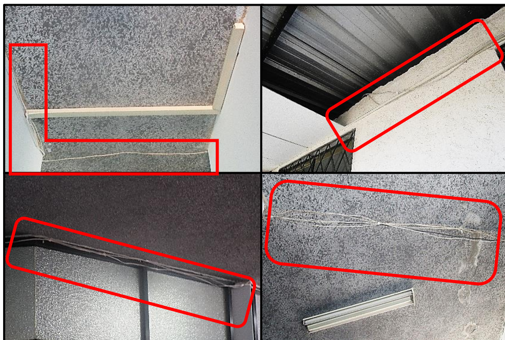
Figura 7: Recorrido del cableado horizontal
