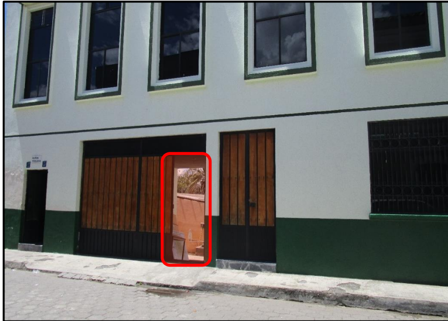
Imagen 3: Puerta de acceso calle Gonzáles Suárez
