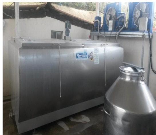
Ilustración 19. Tanques de recepción de leche
