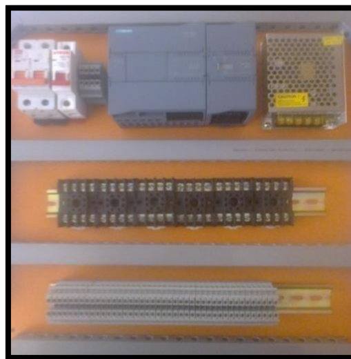
FIGURA 18: Construcción parte interna del tablero "Elaboración propia"
