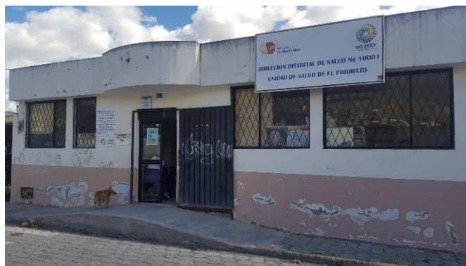
Instalaciones del Centro de Salud Priorato.
