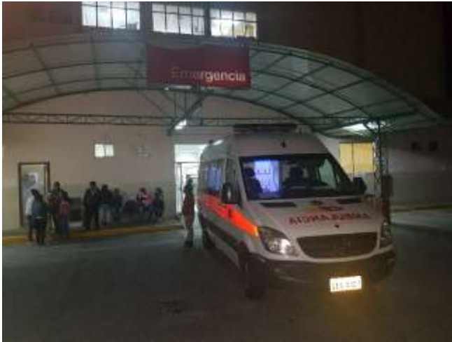
Descripción: ingreso al servicio de emergencias Fuente: Gilbert campos.
