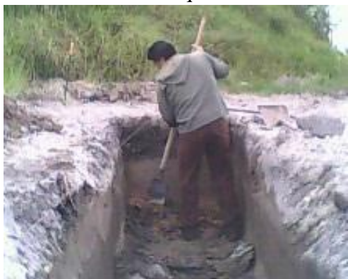
FOTO 2 Delimitación y Nivelación del estanque
