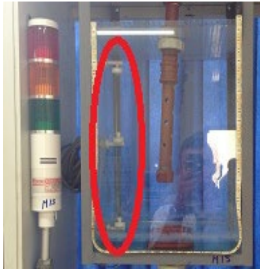
Fig. 9.28 Sensores de nivel
