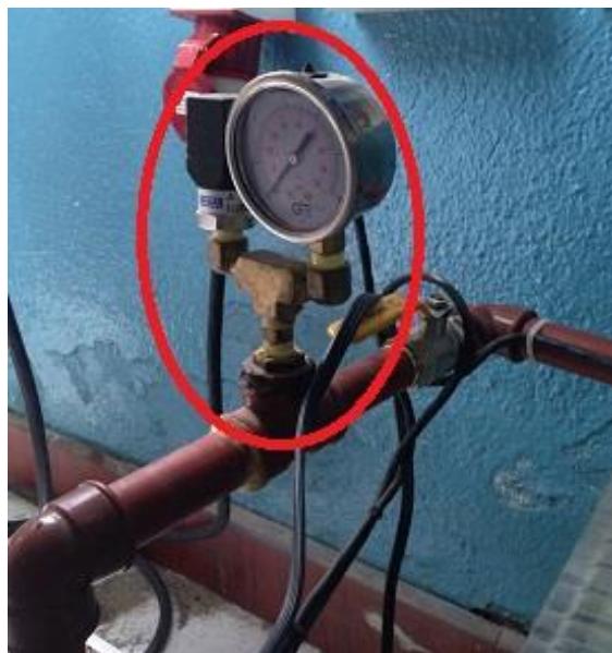
Fig. 30 Manómetro
