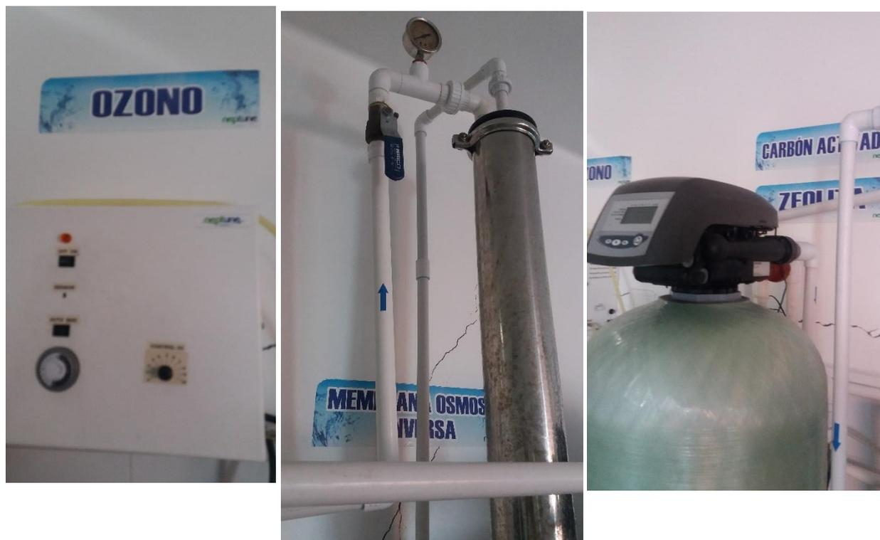
Fotografía 6,7,8: maquinaria de ozono, osmosis inversa, carbono activado y zeolita.
