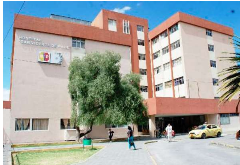
Figura 1. Hospital San Vicente de Paúl - Ibarra
